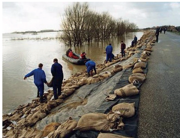
Dijkversterking door zandzakken zakken kunnen worden neergelegd op kritieke momenten
