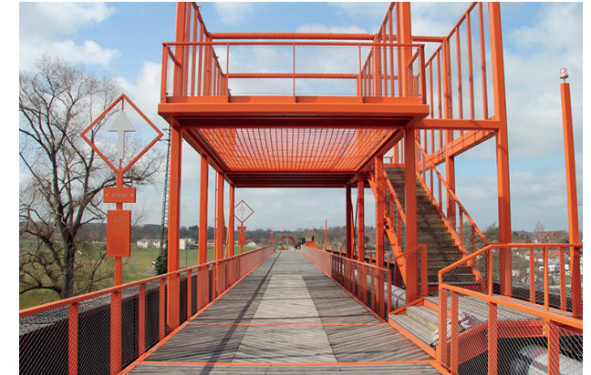
Gekleurde elementen zoals uitzichtpunten Brug in Moulins, Frankrijk
