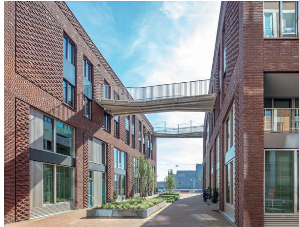
Bruggen als verbindinder Groene Kaap, Rotterdam
