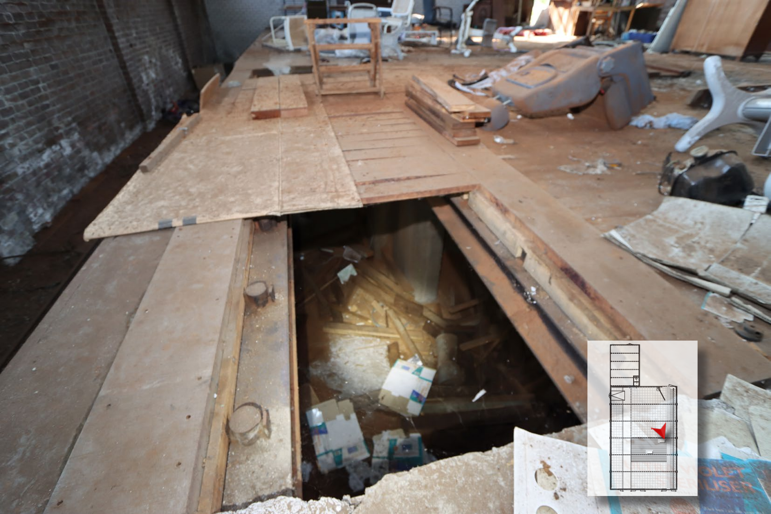
AFBEELDING (boven): Het luik in de vloer bij de verdiepte lorriebaan AFBEELDING (onder): Het dikke vloerhout met de losse veren
