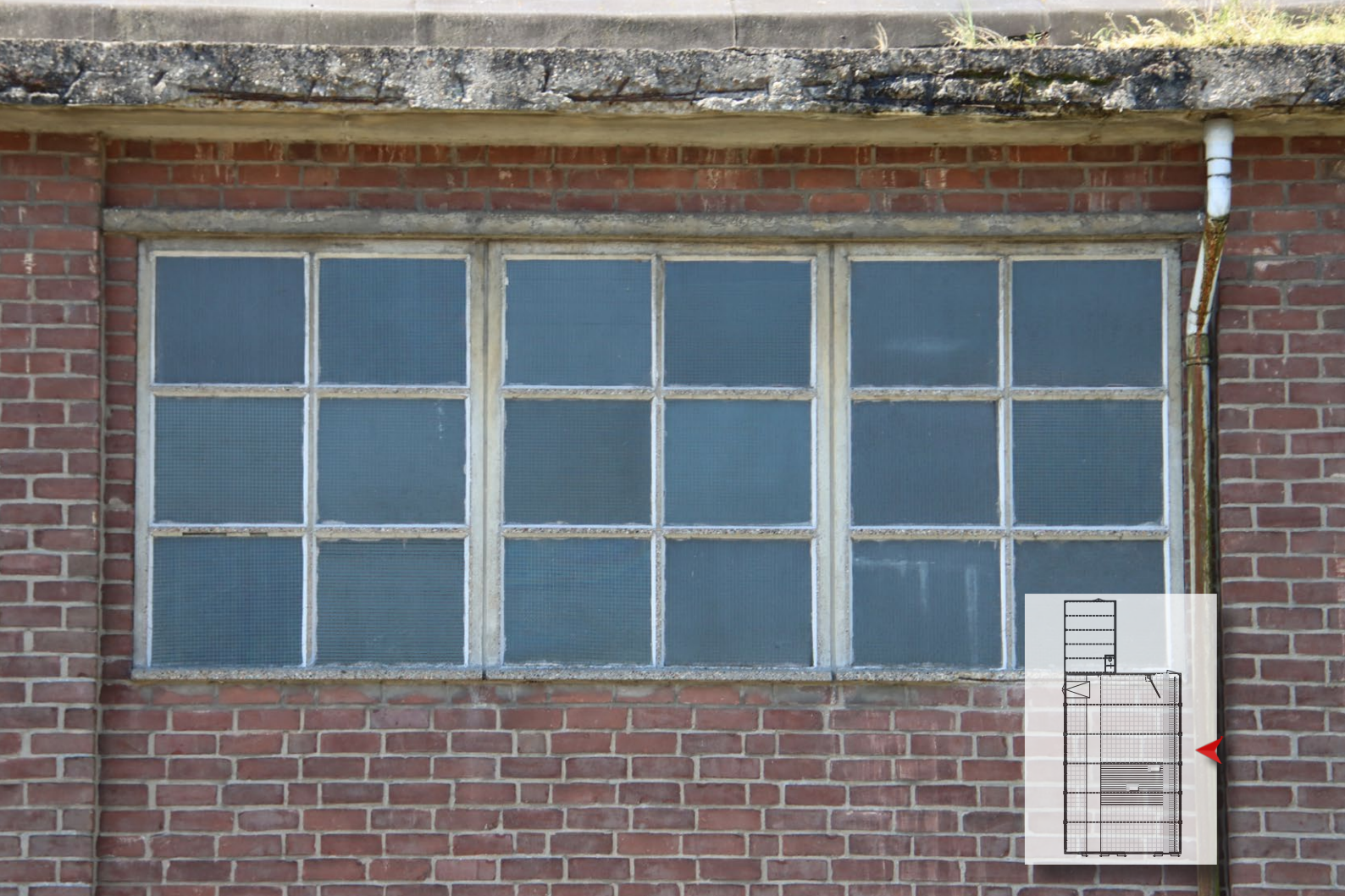
AFBEELDING (boven): Detail van de betonnen ramen AFBEELDING (onder): De zuidgevel
