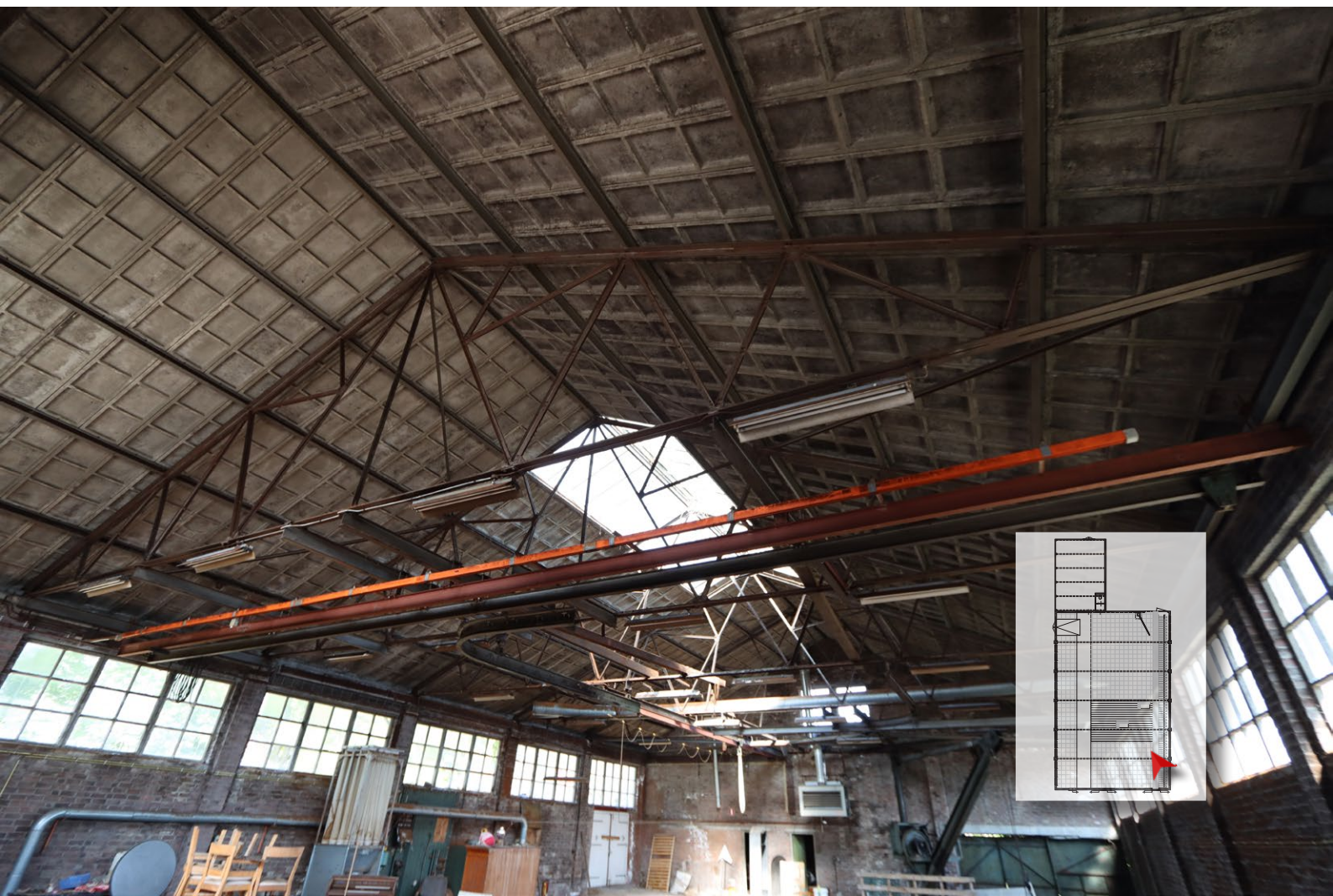
AFBEELDING (boven en onder): De Hollandse vakwerkspanten van 1948 waaraan verschillende geleiderails bevestigd zijn
