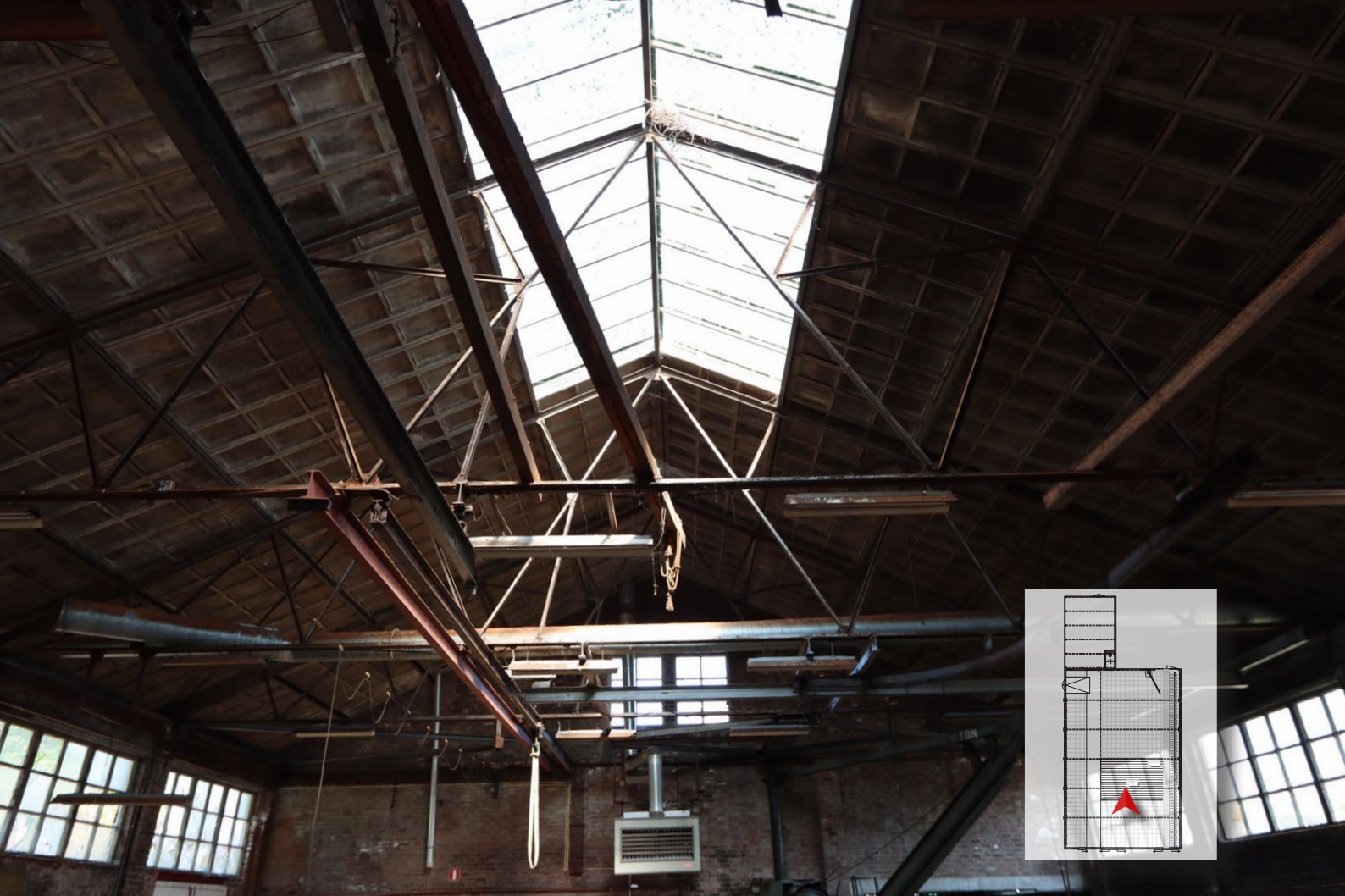
AFBEELDING (boven en onder): De Hollandse vakwerkspanten van 1948 waaraan verschillende geleiderails bevestigd zijn
