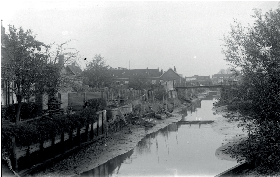
Afb. 16. De inlaat van het Papegat in de periode 1930-1939 gezien vanaf de brug in de 's-Gravendeelsdijk in oostelijke richting. Links zijn de woningen op de noordelijke Weeskinderendijk te zien en rechts, gescheiden door de voormalige doorvaart in het Papegat het terrein van de groenteveiling aan de voormalige dijk van de Zuidpolder (de huidige Weeskinderendijk boven/beneden). Voor het fotostandpunt en richting zie afb. 17, nr. 1 (RAD inventarisnr. 552_319769).
