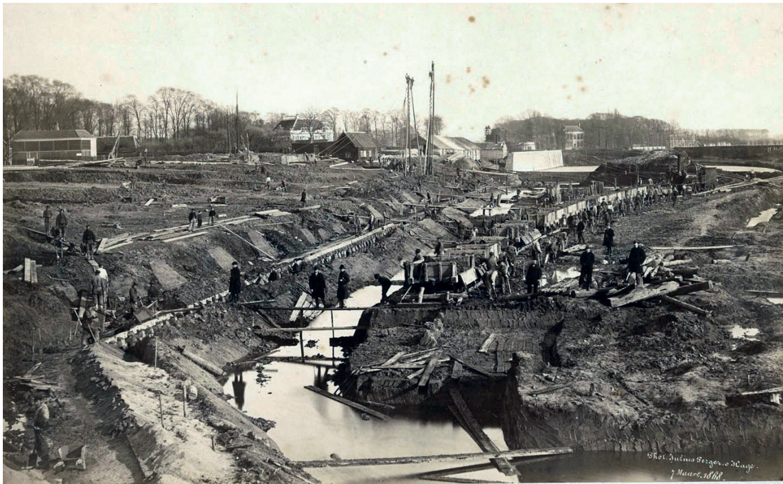
Afb. 15. De aanleg van de Spoorweghaven en de spoorlijn Dordrecht-Rotterdam in 1869, gezien in oostelijke richting. Op de achtergrond zijn van links naar rechts te zien: de 18 e -eeuwse villa Rozenhof, de molen Oranjeboom en de buitenplaats Weizigt met links de orangerie en rechts het koetshuis (RAD inventarisnr. 552_330878).
