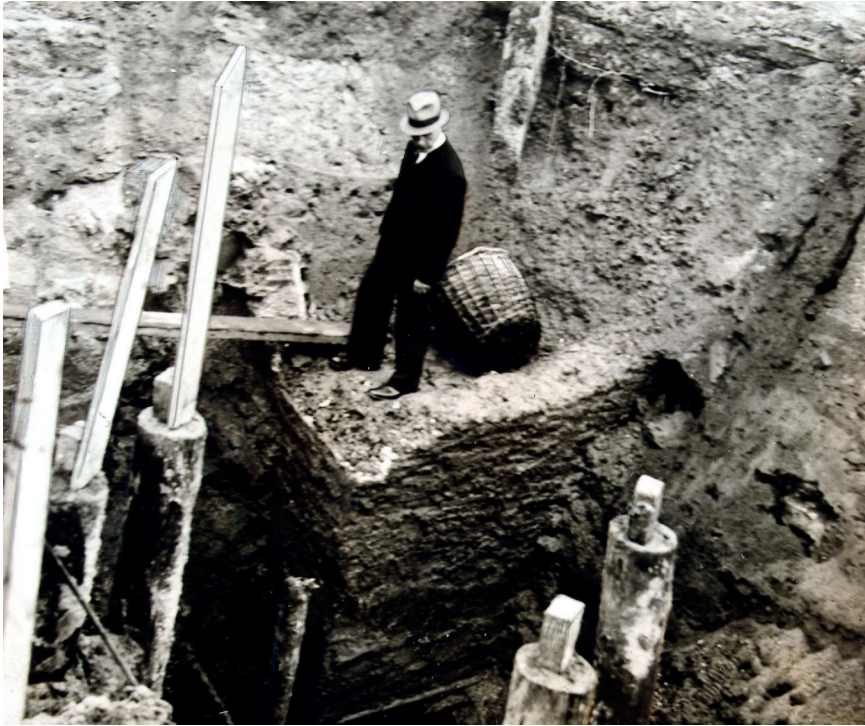
Afb. 20. De aangetroffen fundering tijdens de aanleg van een pijler van het viaduct naar de verkeersbrug naar Zwijndrecht in 1938. Volgens de beschrijving zou dit onder de eerste pijler liggen en zouden dit de fundamente van de sluis van de polder Oud-Dubbeldam zijn. De locatie, aard en ouderdom van deze sluis(?)fundering is echter onzeker (RAD inventarisnr. 555_15217).
