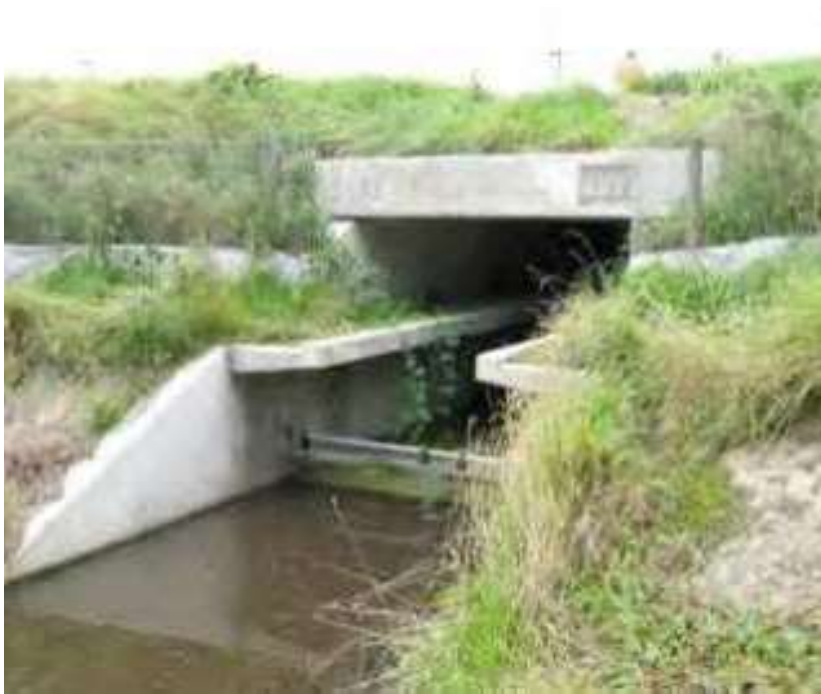
Fig. 10.52 Prefab duiker met betonnen loopstroken
