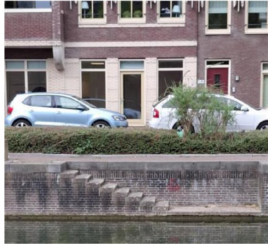
Figuur 79: Foto van de historische trap bij de Spuiboulevard.
