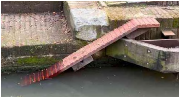
Figuur 44 & 45: Faunatrapp in Utrecht (links) (HIP groen, 2025) en rechts een faunatrapp in de sluis van Bakkeveen (Vaart, 2024).
