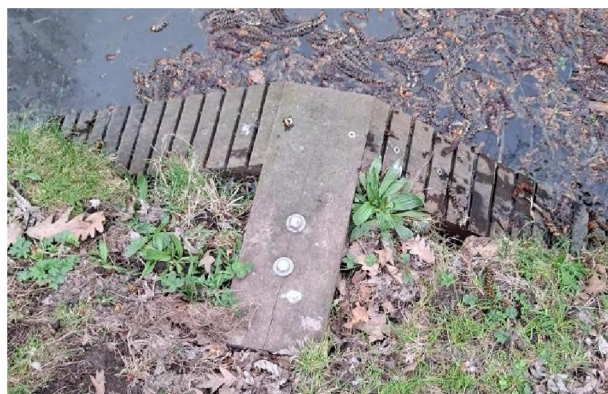
Figuren 53 (links) en 54 (rechts): Figuur 53 laat de faunatrap zien met een versterkingshoek. Figuur 54 laat de bevestiging zien via de uittrede plank met twee schroeven.
