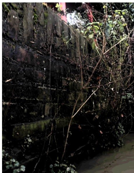
Figuur 71: Afbeelding van het metselwerk van de kademuur (Heijnen, 2022).
