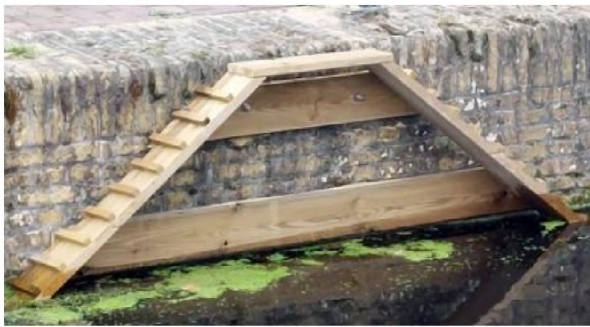
Figuur 44 & 45: Faunatrapp in Utrecht (links) (HIP groen, 2025) en rechts een faunatrapp in de sluis van Bakkeveen (Vaart, 2024).
