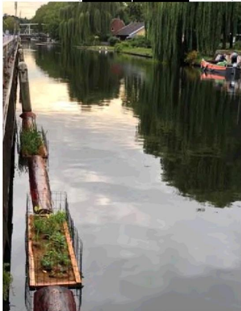
Figuur 30 & 31: Links een faunatrap van beton (v.d. [redacted], 2025) en rechts een trap gelegen achter een damwand ([redacted], 2025).
