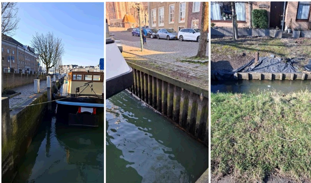
Figuur 12, 13 & 14: Foto's van een kademuur bij Achterhakkers, stalen damwand bij Kalkhaven en houten beschoeiing bij Rijksstraatweg.
