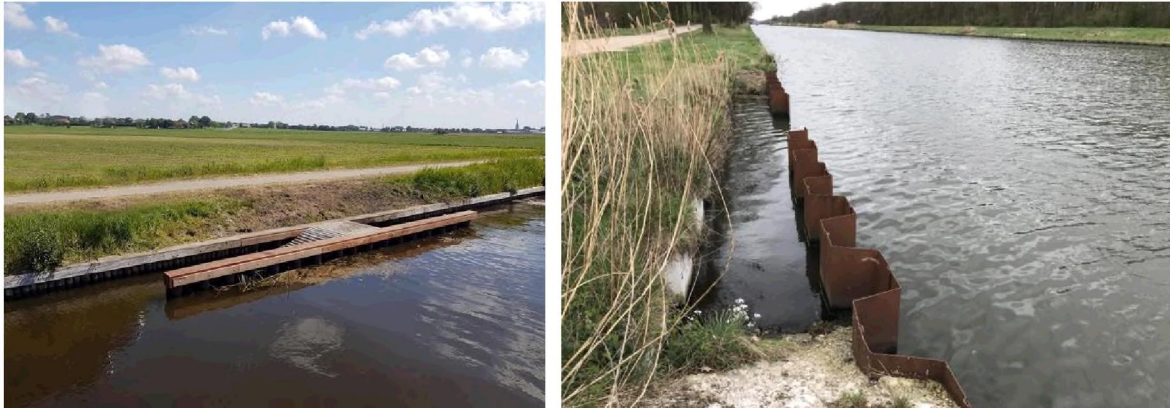
Figuur 30 & 31: Links een faunatrap van beton (v.d. [redacted], 2025) en rechts een trap gelegen achter een damwand ([redacted], 2025).
