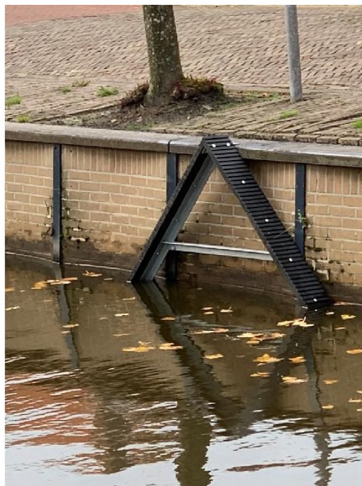
Figuur 41: Faunatrapp met een stalen hoeklijn
