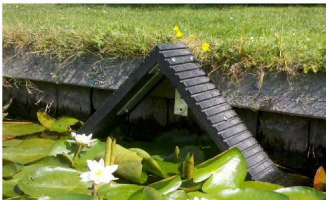
Figuur 37 (linksboven), 38 (rechtsboven) en 39 (onder): faunatrappen met andere hellingshoeken (linksboven), schuin geplaatste faunatrapp (rechtsboven) en een faunatrapp geplaatst aan een oever (onder) (Fauna Support, 2025).
