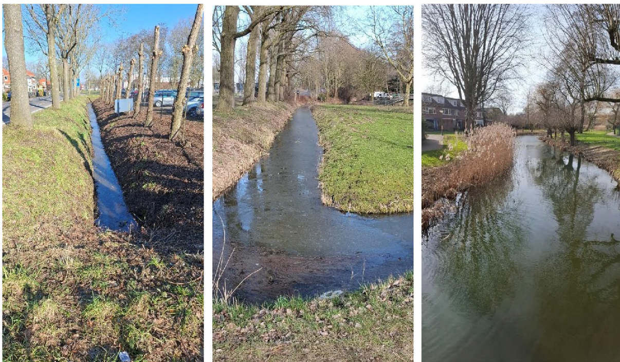
Figuren 17 t/m 19, foto's van verschillende taluds: 17 bij Rijksstraatweg (links), 18 bij Amstelwijckweg (midden) en 19 (rechts).
