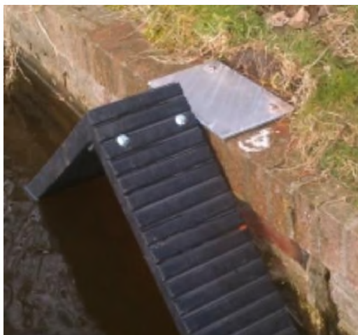
Figuren 51 en 52: Figuur 51 (links) laat de bevestiging aan beschoeiing zien en figuur 52 (rechts) de bevestiging aan een zwakkere kademuur.
