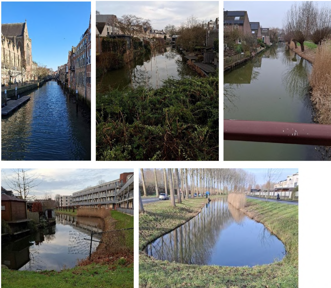
Figuur 23, 24, 25, 26 en 27: Foto's van de verschillende situaties. Figuur 23 bij Pottenkade (linksboven) en figuur 24 bij Bakema-Erf (midden) waar aan beide kanten beschoeiing aanwezig is. Figuur 25 (rechtsboven) en 26 bij Bakema-Erf (linksonder) waar aan een kant beschoeiing zit en de andere kant een talud. En figuur 27 bij Groenezoom waar aan beide kanten een talud aanwezig is.
