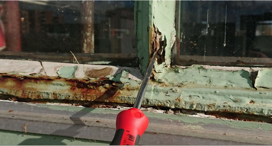
Boven/ onder, kozijnen van T-profielen stopverf slecht. Onderdorpels slecht
