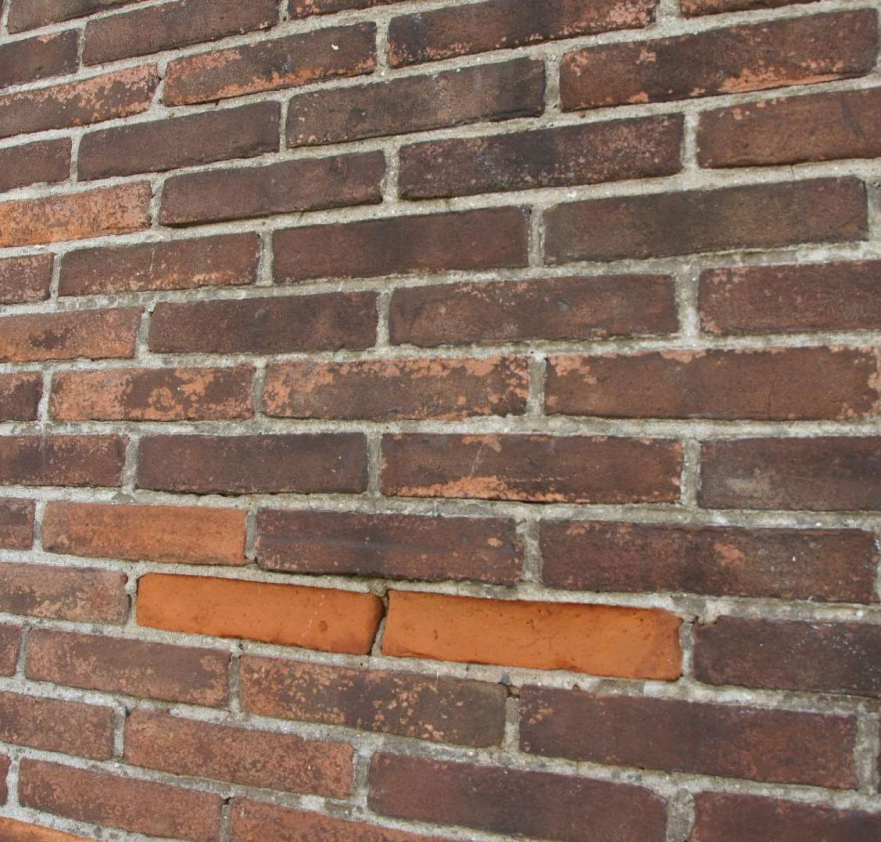
Detail gevelmetselwerk, poreuze bakstenen
