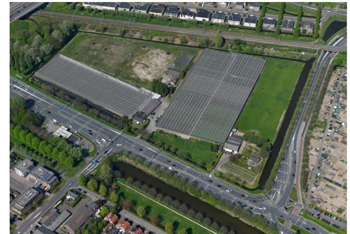
Luchtfoto huidige situatie
