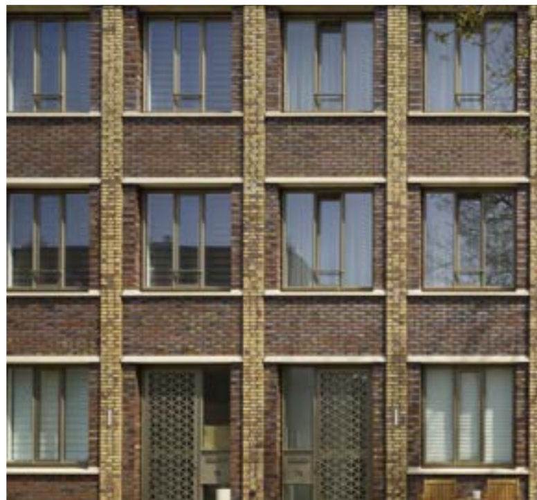
RIJKE DETAILLERING MET VERSCHILLENDE METSELVERBANDEN
