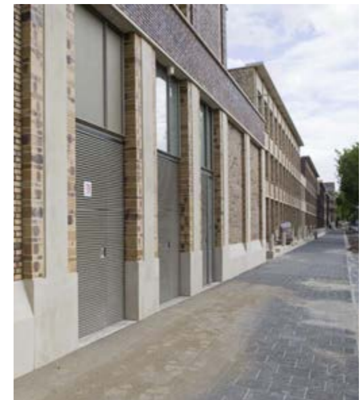
INTEGRATIE NUTSRUIMTE IN GEVELRITME
