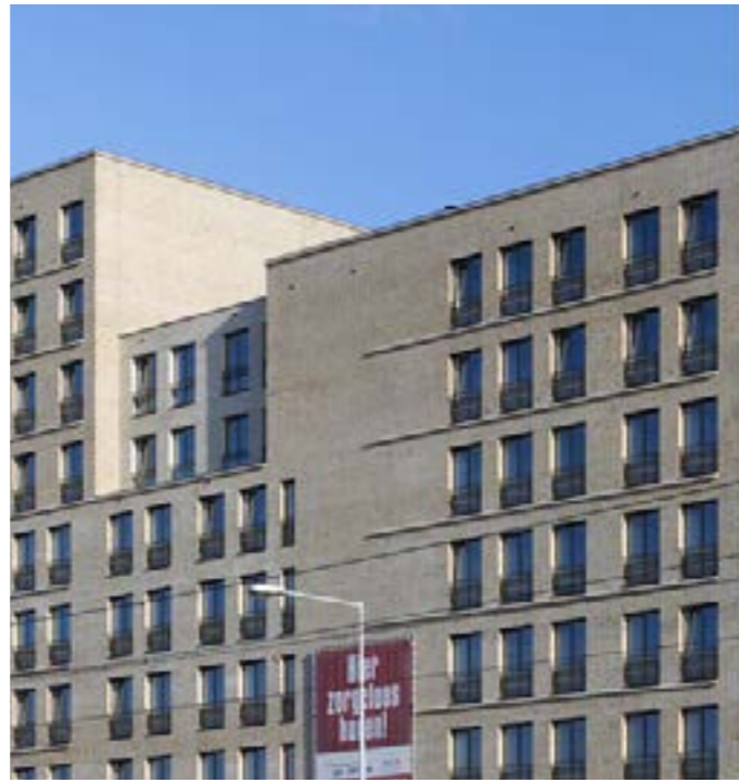
ANDREAS ENSEMBLE AMSTERDAM - DOVE GEVEL BEWASSINGSRAAM EN MECHANISCH SPIJEN
