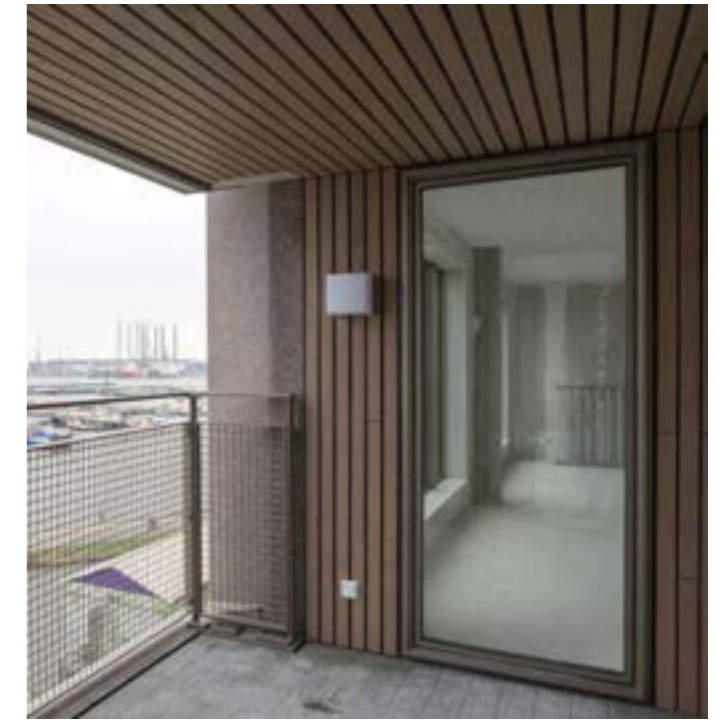
HOUTHAVENS AMSTERDAM GELUIDSDEMPENDE BEKLEDING LOGGIA
