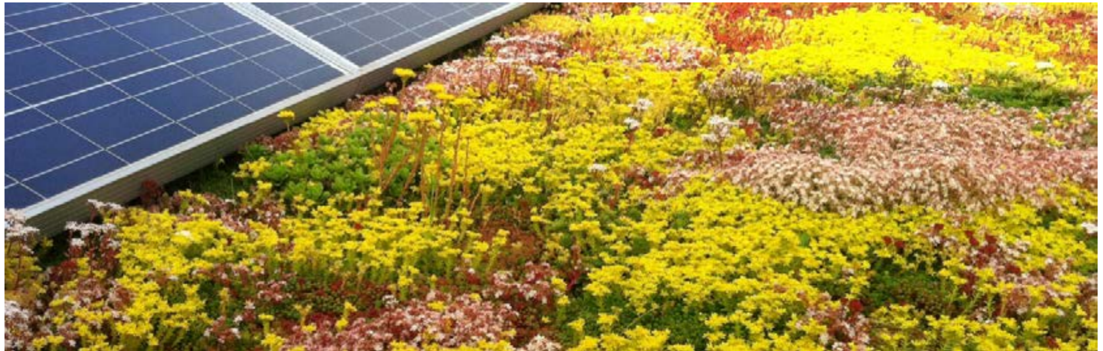
GROEN DAK, MOS SEDUM EN PV PANELEN
