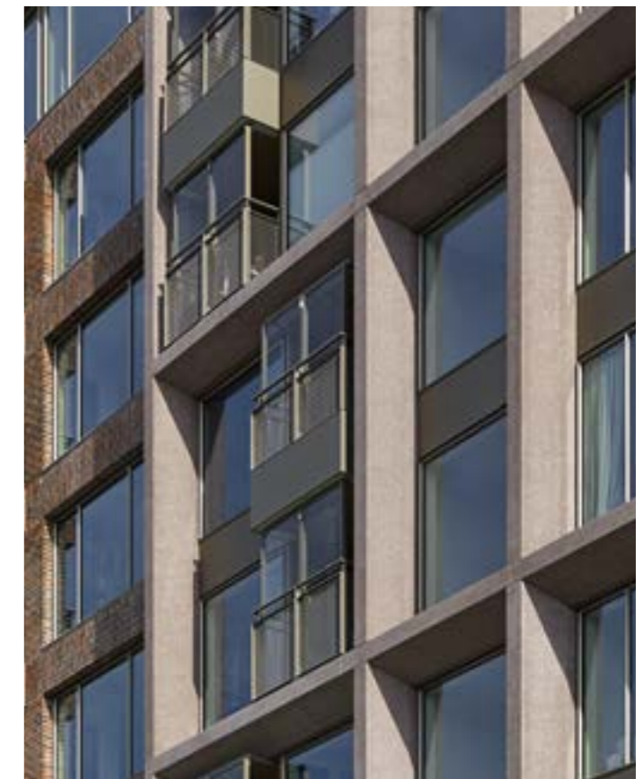
HOUTHAVENS AMSTERDAM DOVE GEVEL MET GELUIDSSCHERM LOGGIA
