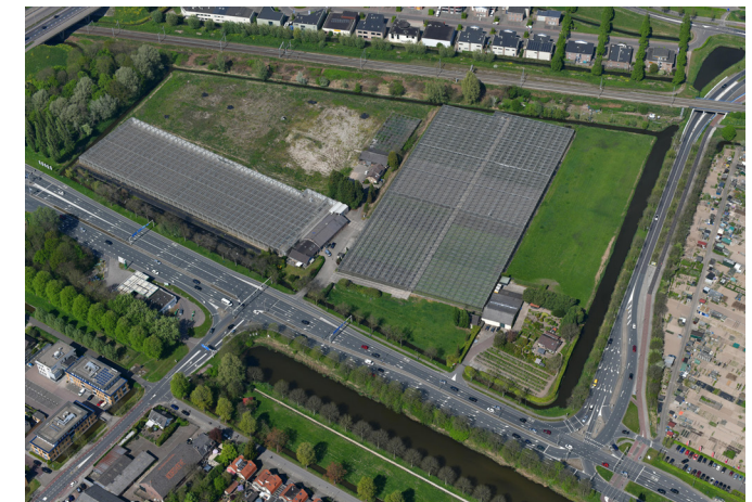
Luchtfoto huidige situatie
