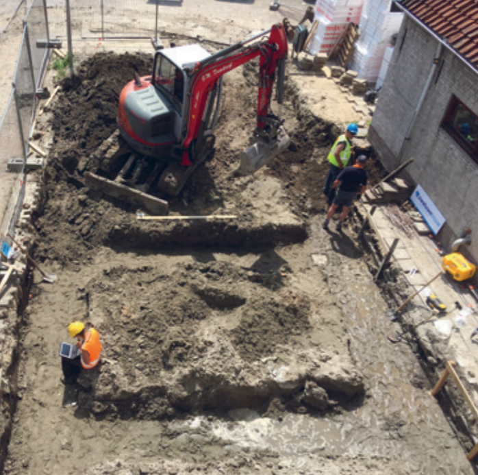
De funderingssleuven worden voor een deel in het opgebrachte zand gegraven en onderzocht door 2 archeologen van RAAP.
