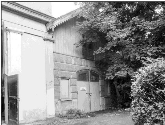
Afb. 2.46: De voorgevel (oost) van het washuis. Links de zijgevel van de orangerie. Foto uit 1985, G.J. Dukker. (Herkomst: RCE, obj.nr.258.984.)
