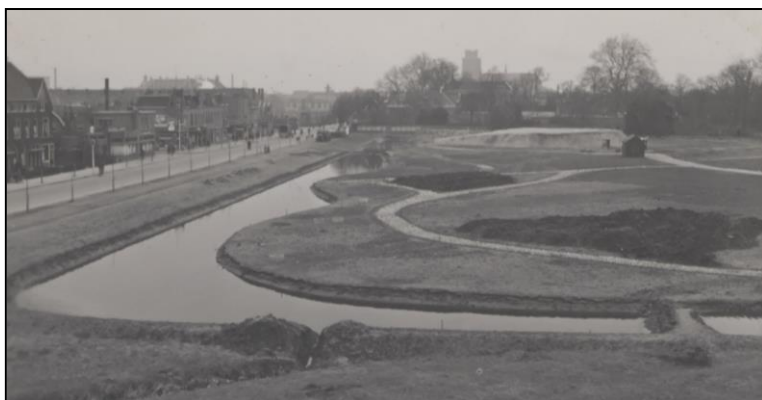
Afb. U: Zicht op de zuidwesthoek van het Weizichtpark tijdens de aanleg, foto 1947-1948. (Herkomst: RAD, inv.nr.552_3015005.)
