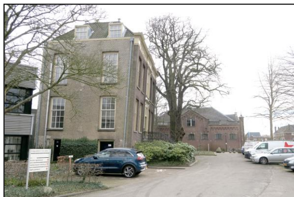
Afb. 1.4: Huis Weizigt en het koetshuis, gezien vanuit het noorden. De voorgevel van het hoofdhuis helt opvallend voorover. Links een gedeelte van het moderne kantoorgebouw van Woonbron.
