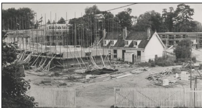
Afb. W: Bejaardentehuis Thureborgh in aanbouw met daartussen de voormalige dienstwoningen van buitenplaats Weizigt, foto 1960. (Herkomst: RAD, inv.nr.552_320023.)
