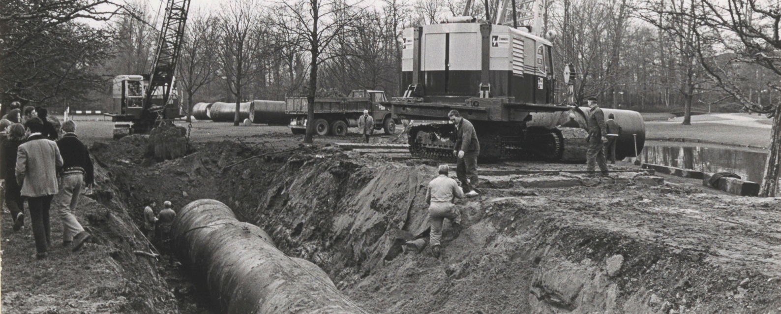
Afb. 1.13 - Aanleg van de hoofdrioolleiding door het Weizigtpark in 1972.
