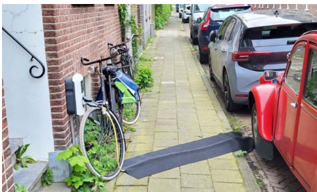
Kabel onder een kabelmat
