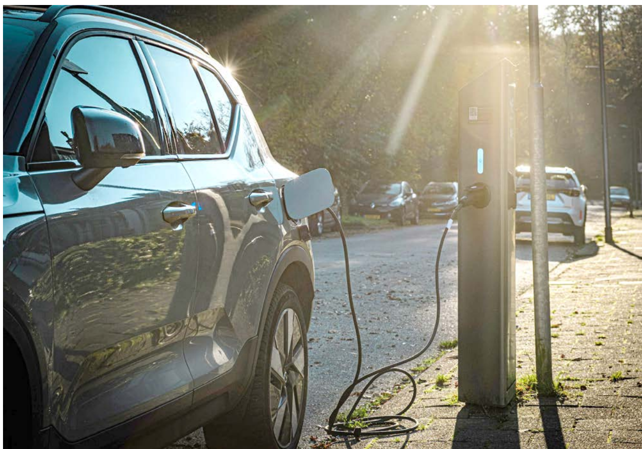
Figuur 7. Voorbeeld van een laadpaal (Foto Otto van Boggelen)
