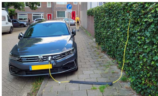
Kabel onder een kabelbrug
