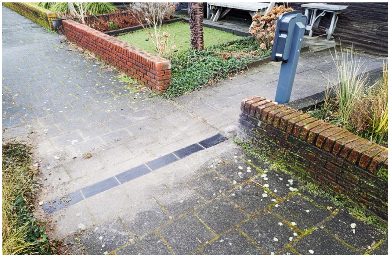
Figuur 5. Voorbeeld van toepassing van een kabelgoot (Foto gemeente Zeist)
