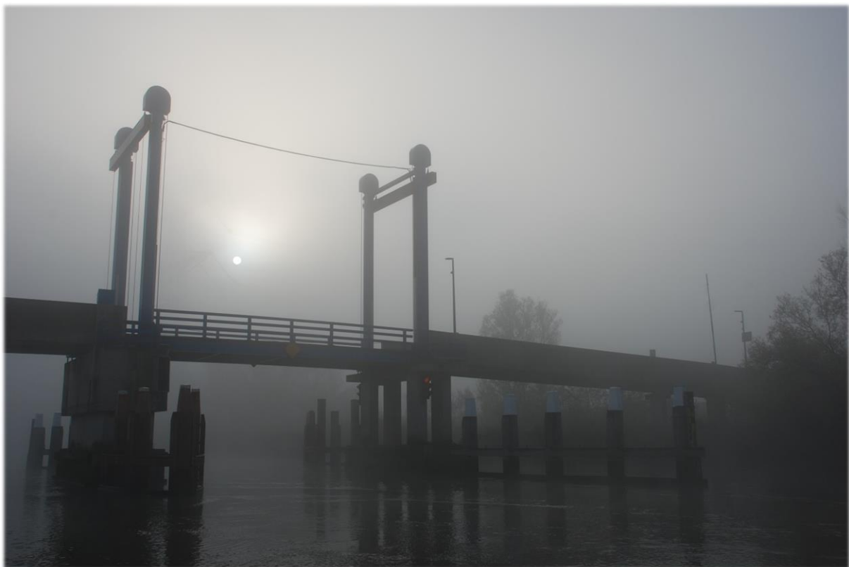
De Wantijfietsbrug. Een verbinding tussen de wijk Stadspolders en de Sionpolder.
