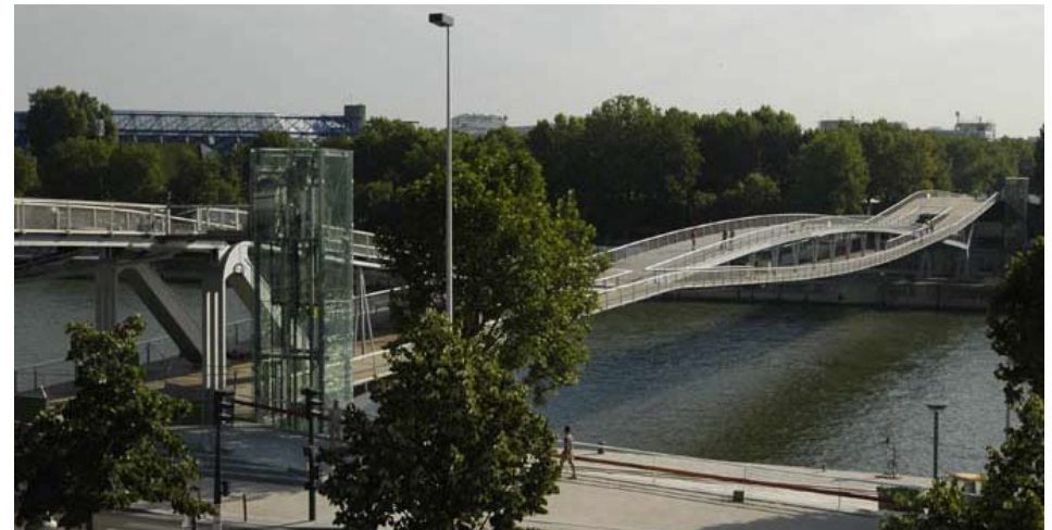
van links naar rechts, boven naar onder: brug tussen Buda en Pest, de Erasmusbrug in Rotterdam, de nieuwe stadsbrug in Maastricht en de Passarele Simone de Beauvoir in Parijs.
