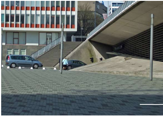
Parkeergarage onder de aanlanding van de brug
