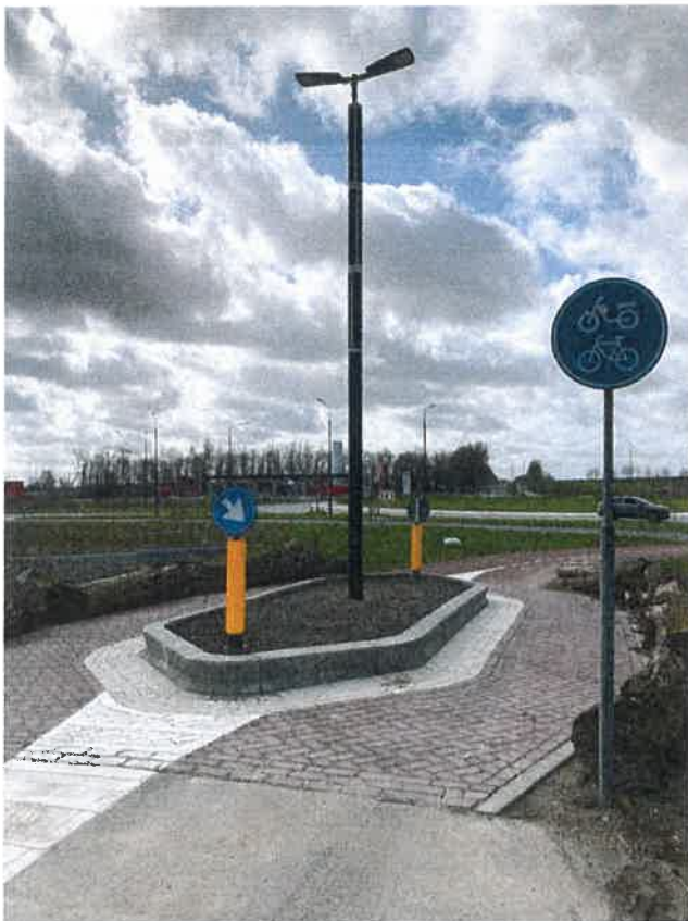
Fietssluis Rijksstraatweg thv de Aquamarijnweg
