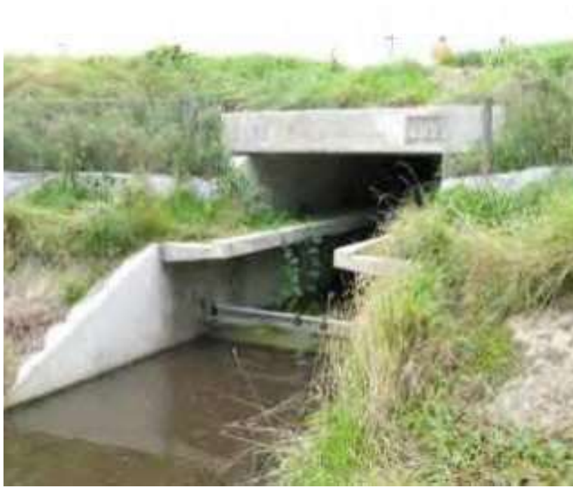
Fig. 10.52 Prefab duiker met betonnen loopstroken
