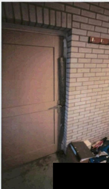
Foto 12: buitendeur gezien vanuit garage
