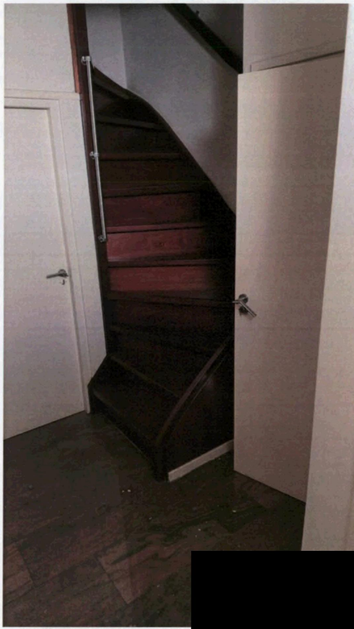
Foto 2: hal bij binnenkomst via voordeur
