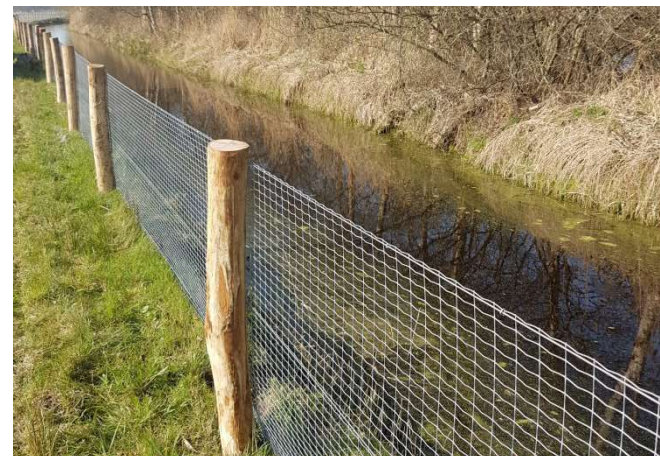
42 Rasters begeleiden bevers en otters naar de faunapassage. Bij voorkeur zijn deze 1 tot 1,5m hoog en minimaal 0,3m in de grond ingegraven. De lengte dient minimaal 50(!)m te zijn.
