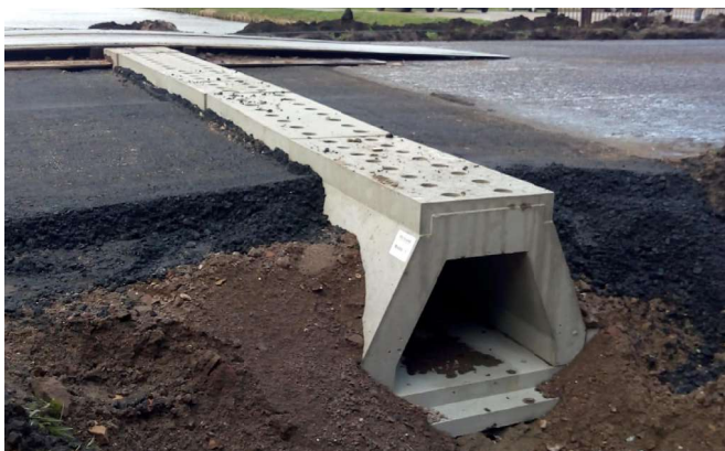
41 Faunapassage voor otter, kikkers, padden, egels, gemaakt van olifantsgras en gerecycled betonpuin. Deze circulaire, biobased (prefab) faunapassage is een milieuvriendelijk alternatief voor een faunapassage gemaakt van traditioneel beton.
