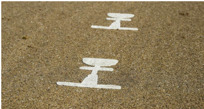
61 Fietspad van Grasfalt® in de gemeente Renkum, aangelegd in 2022. Bron: www.grasfalt.nl
