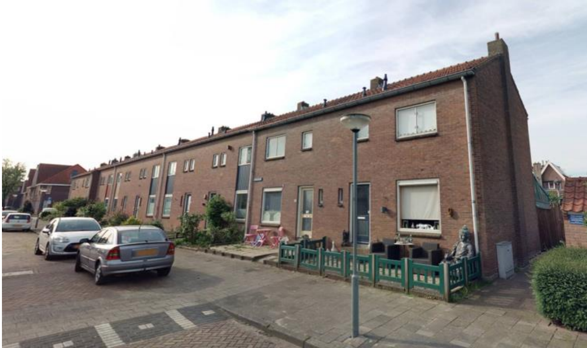
Impressie bestaande woningen zuidzijde Damstraat
