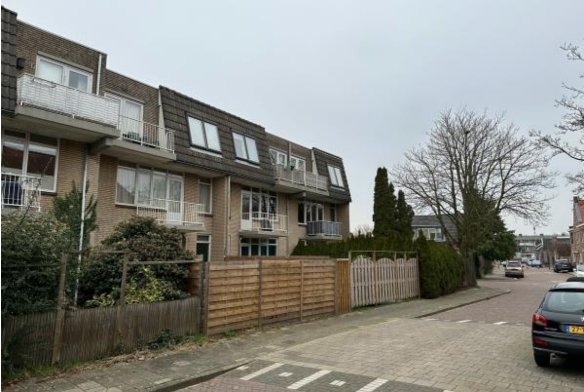
Impressie appartementengebouw Gorterplaats gezien vanaf de Damstraat
