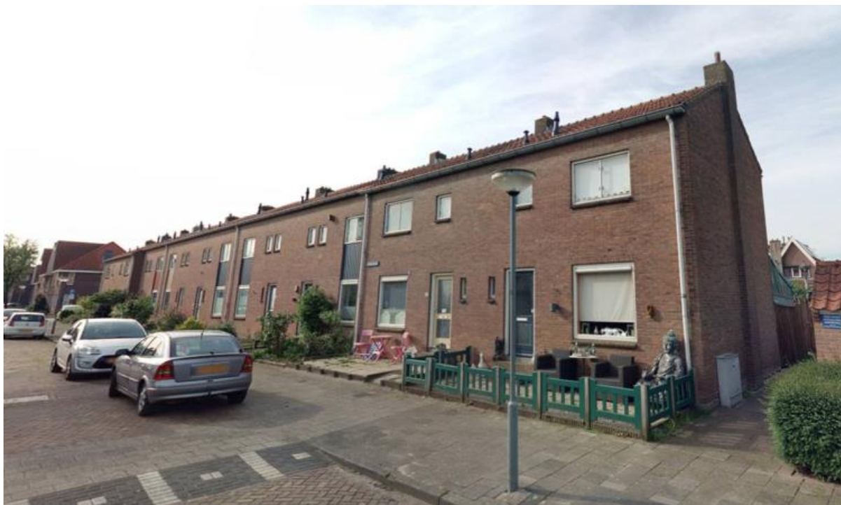
Impressie bestaande woningen zuidzijde Damstraat
