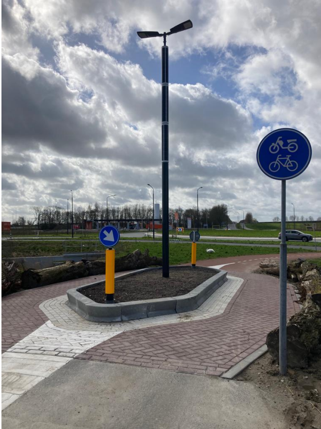
Fietssluis Rijksweg thv de Aquamarijnweg
