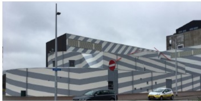
TS-MS station (van 25-66 naar 3-23 kV)
