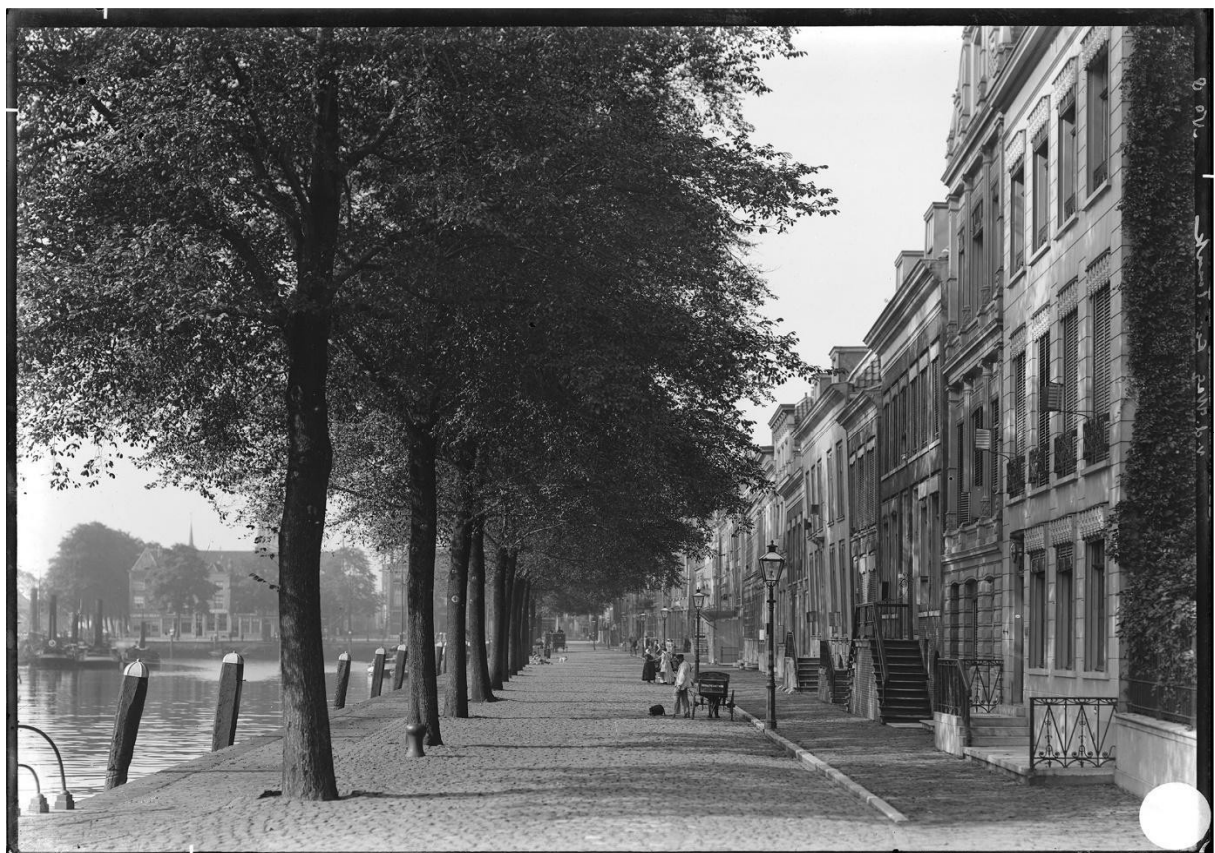
Historische foto Wolwevershaven, met uniforme vlakke bestrating
