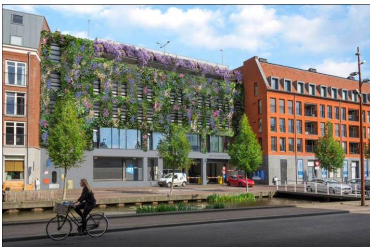
Figuur 2: Parkeergarage De Barones in Breda. Ventilatieroosters blijven open voor ventilatie. foto: BN De Stem
