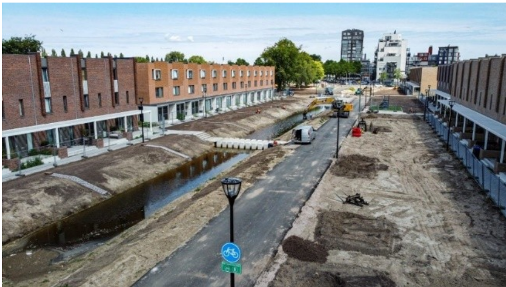
Figuur 24: Foto genomen tijdens de bouw
