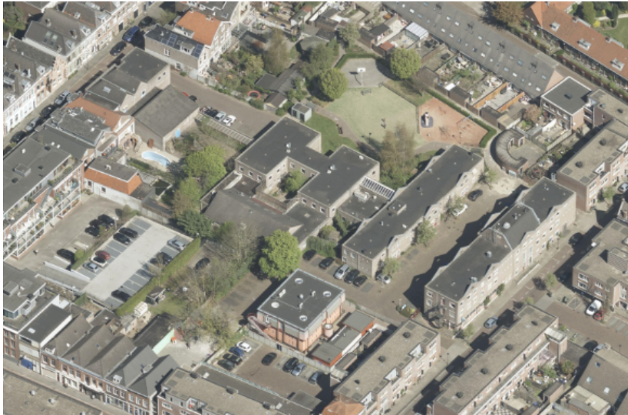
Figuur 3: Luchtfoto bestaande situatie
