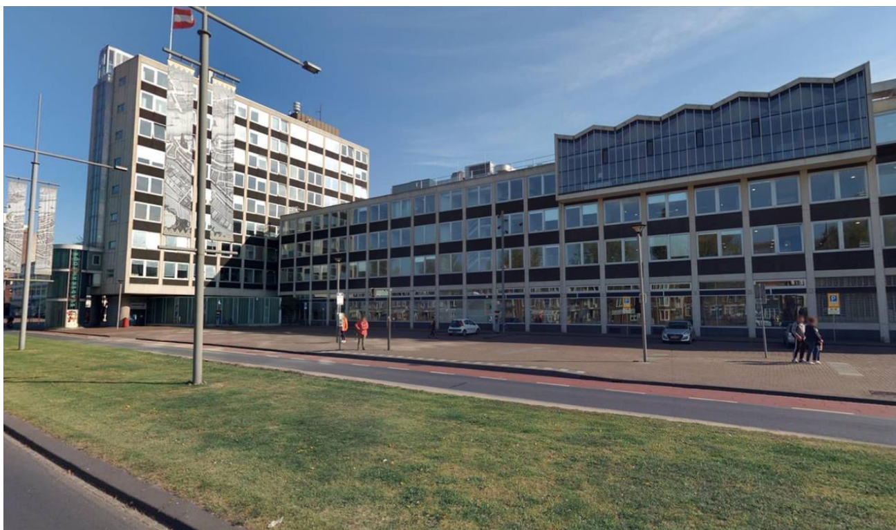
Afbeelding 1.2 het bestaande Stads Kantoor aan de Spuiboulevard 300
