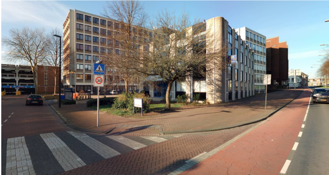
Afbeelding 1.2 het bestaande kantoorgebouw Crownpoint aan de Spuiboulevard 314
