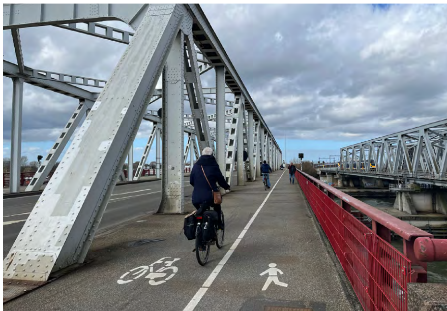
Voet- en fietspad op de stadsbrug Dordrecht-Zwijndrecht
