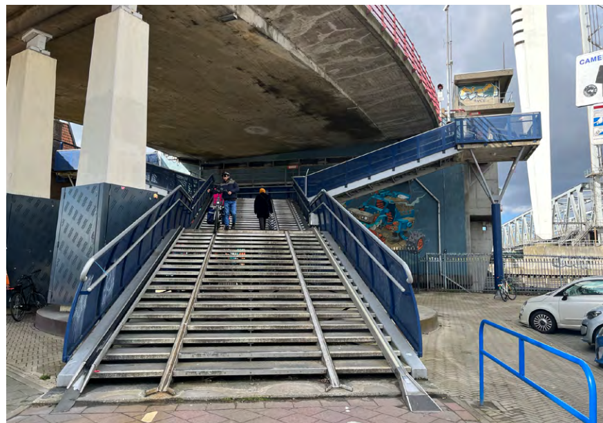
Aanlanding met trappen bij stadsbrug Dordrecht-Zwijndrecht
