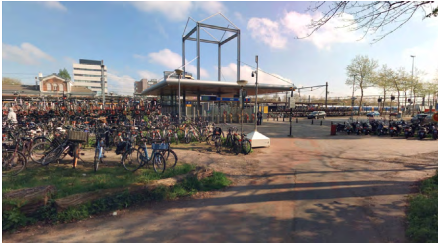
De huidige en nieuwe situatie aan de zuidzijde van station Dordrecht
