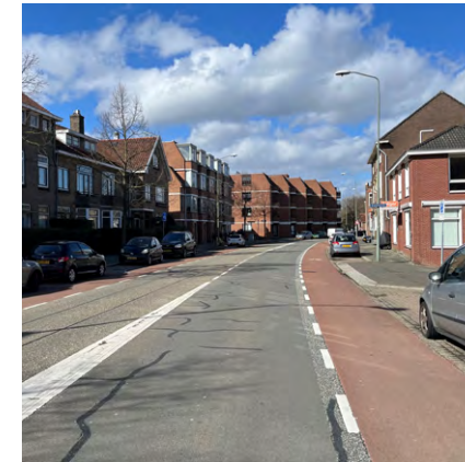
Huidige situatie Krommedijk
