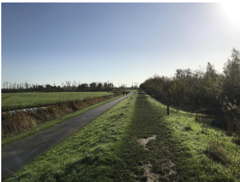
Afbeelding 3.2 Bestaande situatie: kade met wandelpad op de kruin en asfaltweg aan de voet
